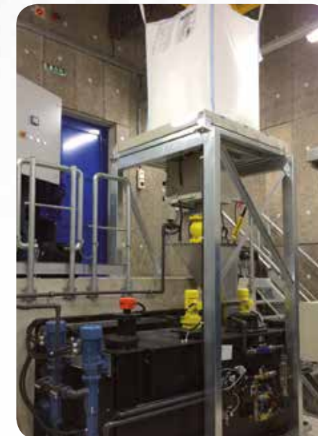
Dozator și dizolvant unic de pulbere - (Big Bag)
