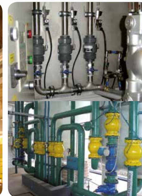
Fabrică de motor:- unitate de diluare lac Uzina de apă :- apă de spălare
