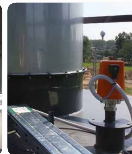
Prelucrarea fructelor: măsurarea nivelului hidratului de calcar, a silozului
