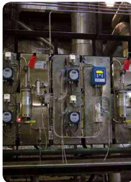
Sistem central pentru măsurarea pH-ului și a conductivității
