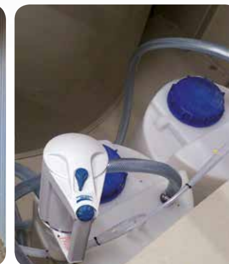
Laborator de chimie – neutralizarea apei uzate
