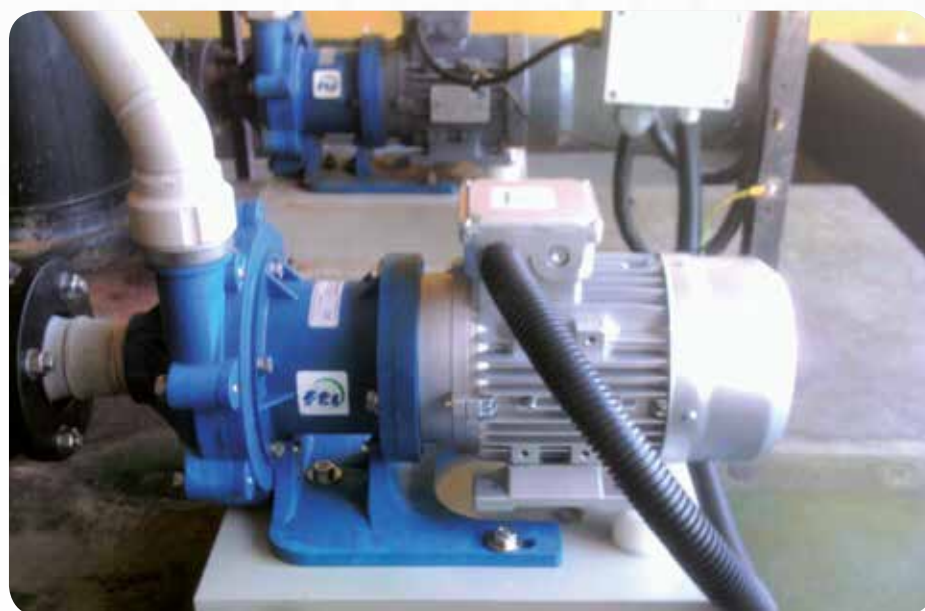
Transvazarea acidului - fabrica de detergent
